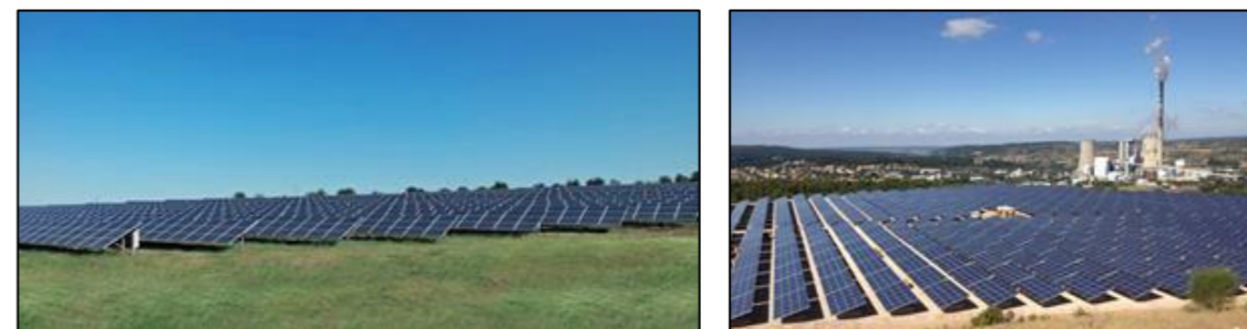
Figure 22 : Réalisations d'URBASOLAR : à gauche, Granitec en Bulgarie ; à droite, aménagement d'un ancien terroir à Gardanne (13) (Crédit photo : URBASOLAR)
