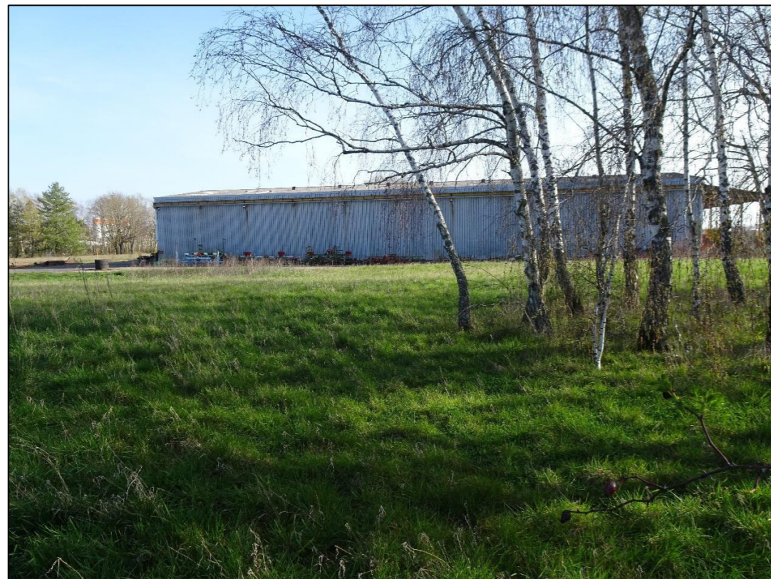
Prise de vue B : Vue depuis l'est du site d'étude en direction du nord-est
