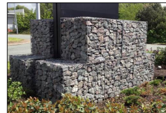
Figure 27 : Exemple de muret en gabion (Source : TCS Geotechnics)
